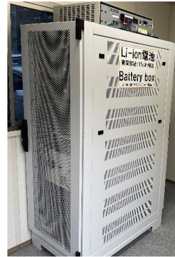
Li-ion電池ユニット (15kWh)
